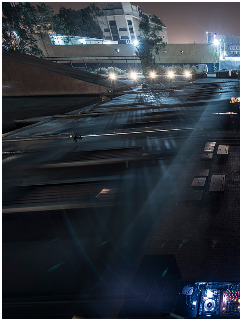
Fase di ritrazione dei pannelli di copertura. Bernard Khoury, B018, 1998, Beirut (Libano). © Bernard Khoury
