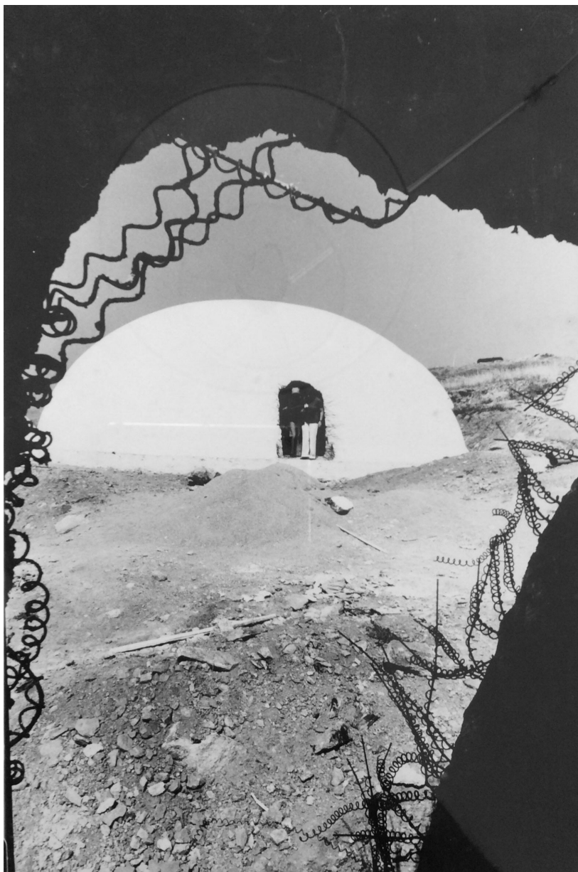
Fotografie di cantiere delle otto Binishell realizzate a cavallo fra gli anni Sessanta e Settanta all'isola dei Cappuccini, nel parco nazionale dell'Arcipelago di La Maddalena, in Sardegna. Il villaggio di cupole doveva essere completato da una struttura di Frei Otto. © Archivio Dante Bini
