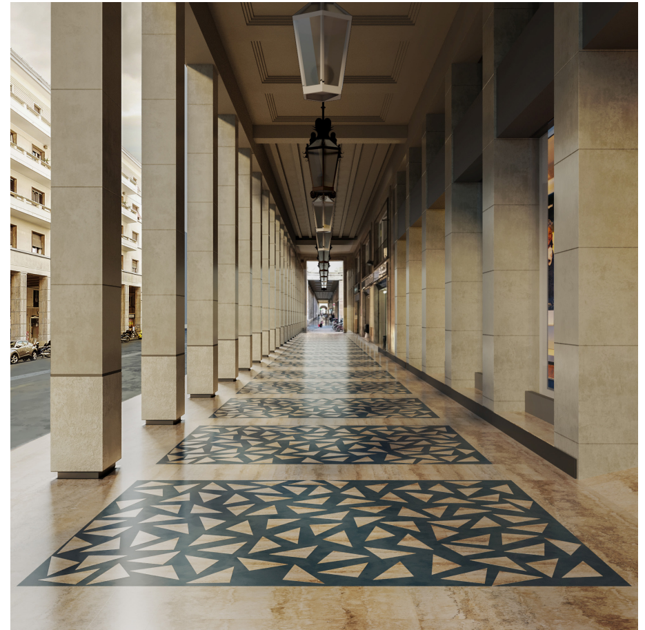
Vista del porticato. Nuovo layout della pavimentazione. © Ipostudio architetti, Quattroterzi Architetti
