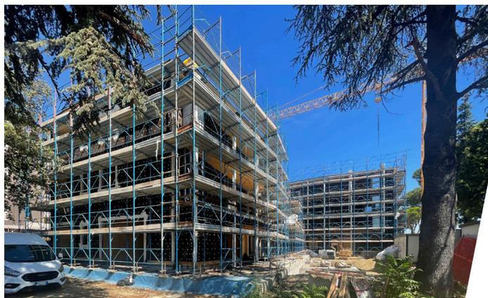
**A lato. Struttura ultimata e posa del cappotto isolante in sughero. A516, 2020-in corso.**
