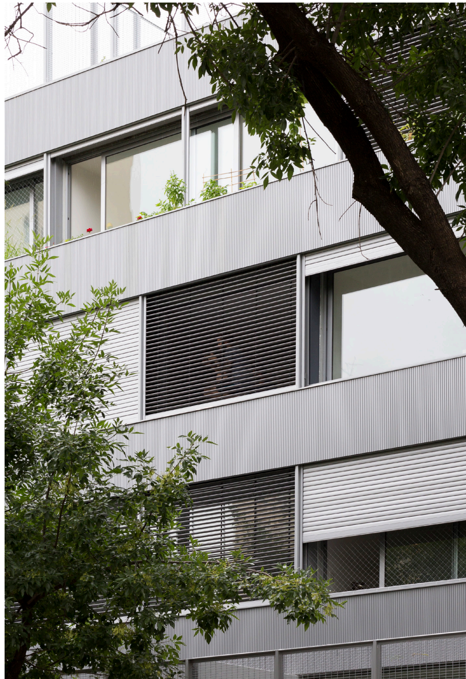
Dettaglio di facciata. Adamo Faiden, La Vecindad de Plaza Mafalda , 2017, Buenos Aires. © Javier Agustín Rojas
