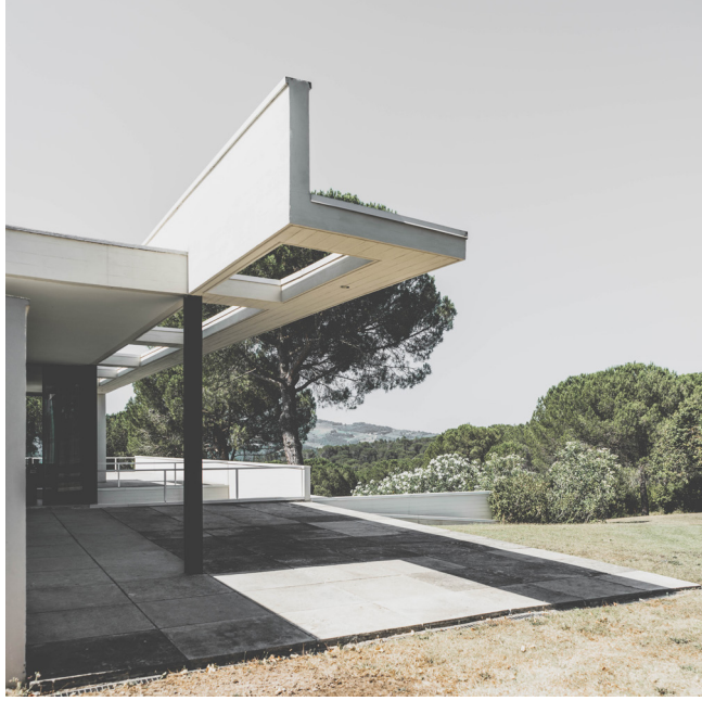
Dettaglio della pensilina d'ingresso. Roberto Monsani, Villa Brody Monsani , 1972-1973, Greve in Chianti (FI). © Quattroterzi Architetti
