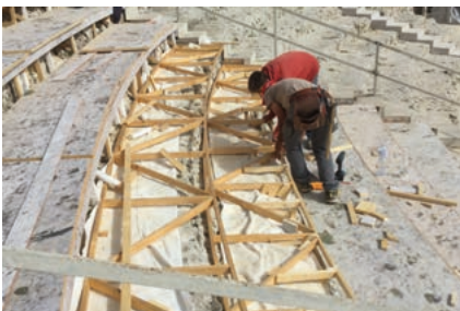
Fig. 11. L'allestimento della cavea per la stagione 2017 durante la costruzione delle inelaiature di sostegno delle sedute in legno.
