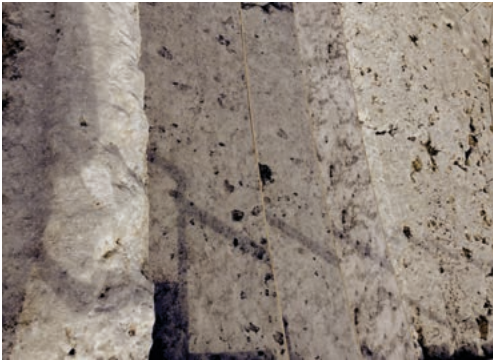
Fig. 10. I gradoni dall'alto, tre dei quali riprodotti mediante stampa a colori digitale ad alta definizione con resine pigmentate sulle sedute in legno.
