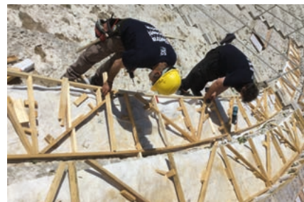
Fig. 12. Operai al lavoro per realizzare le inelaiature di sostegno delle sedute in legno.
