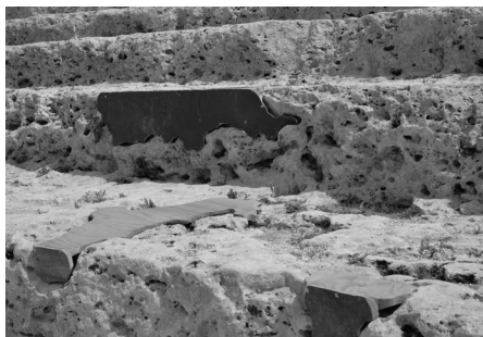
Fig. 3. Protesi in legno rimovibili per l'integrazione delle lacune nella parti della cavea direttamente accessibile al pubblico.
