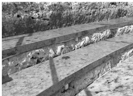
Fig. 6. I primi prototipi delle sedute in legno con stampata la riproduzione fotografica del gradone lapideo sottostante.
