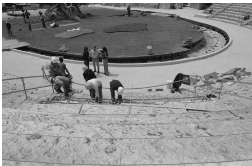
Fig. 13. Uno dei cunei della cavea bassa, appena completato con la realizzazione delle nuove sedute in legno con stampata la riproduzione del gradone in pietra sottostante.
