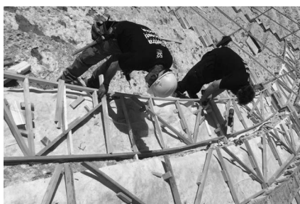
Fig. 12. Operai al lavoro per realizzare le intelaiature di sostegno delle sedute in legno.
