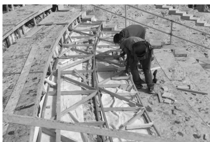
Fig. 11. L'allestimento della cavea per la stagione 2017 durante la costruzione delle intelaiature di sostegno delle sedute in legno.
